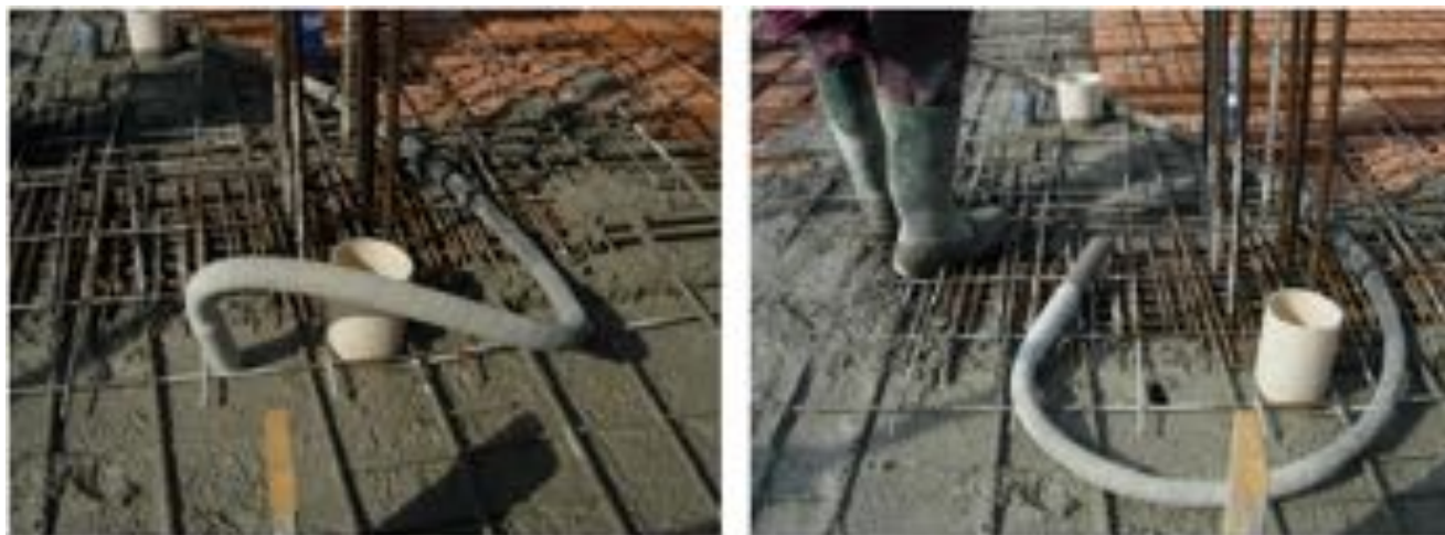
Costipamento dell'impasto nella cassaforma tramite vibratura
