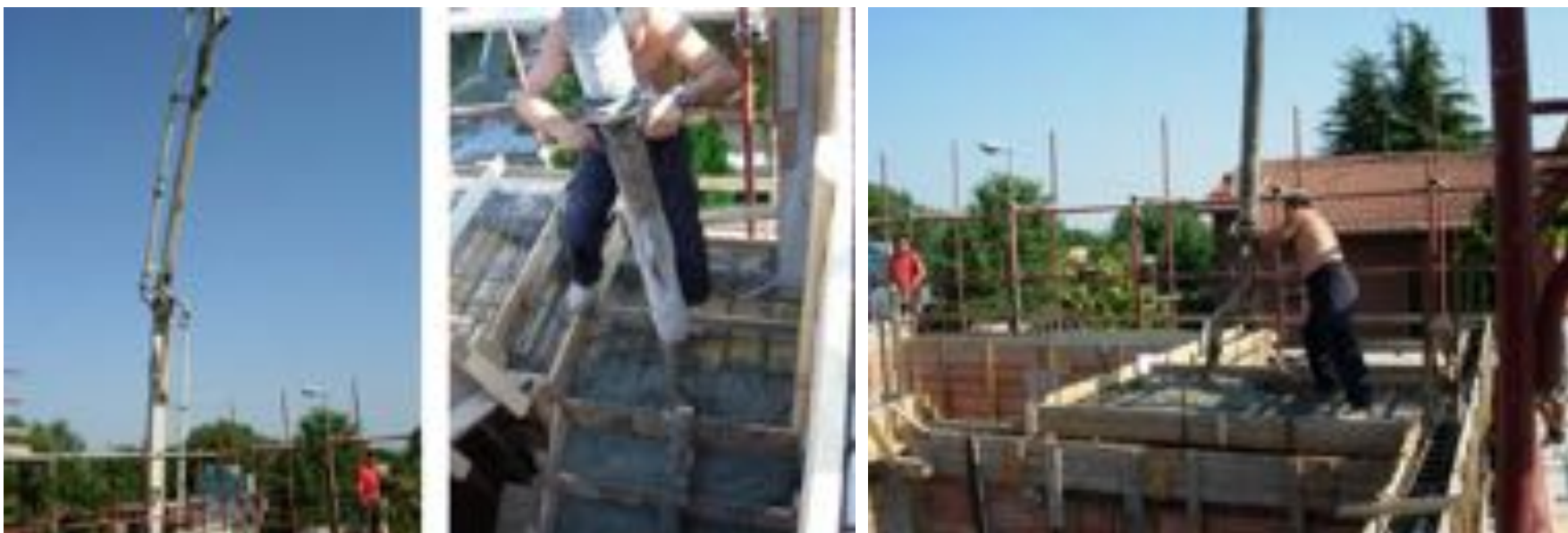
Getto dell'impasto tramite pompa per cls
